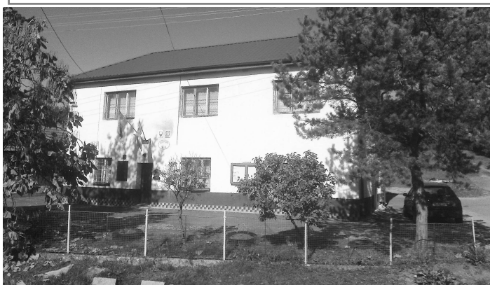
Projekt Rekonštrukcia strechy budovy kultúrneho domu bol podporený sumou 12 000 eur
